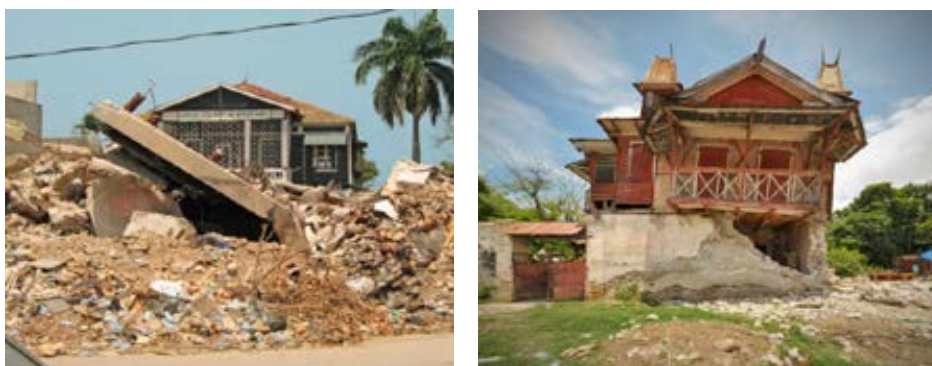
Images 3 et 4. Deux exemples de maisons de style gingerbread, à Léogâne et Port-au-Prince, debout après le tremblement de terre.
