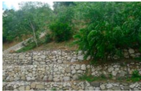
Image 7. Mur de contention de gabion situé pour maintenir la différence de niveau du sol en tant que protection arborée du flanc. Photographie: Teresa Tapada.
