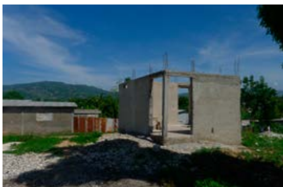
Images 20 et 21. Logements en construction, Mayard. Auteur: Teresa Tapada
